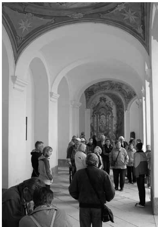
Mariánská Týnice, ambitová chodba je zdobena freskami.
